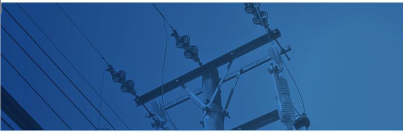
Para estructuras de líneas aéreas de media tensión de 13 a 33 kV, se debe usar como mínimo poste de concreto de 12 m.
